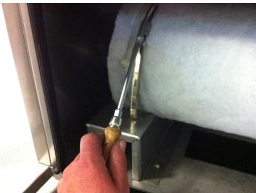
Öffnen Sie die beiden Verbindungsschellen mit einem Schraubendreher und entnehmen dann die Filterpatrone.
